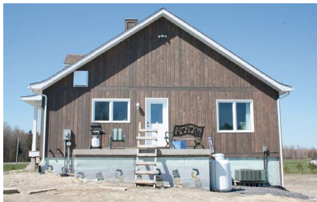
Siding z sosny powstał przy użyciu czterostronnej strugarki PH 260
